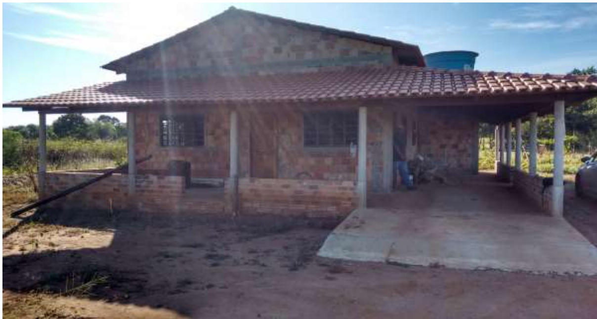
1 – Fachada frontal da residência
