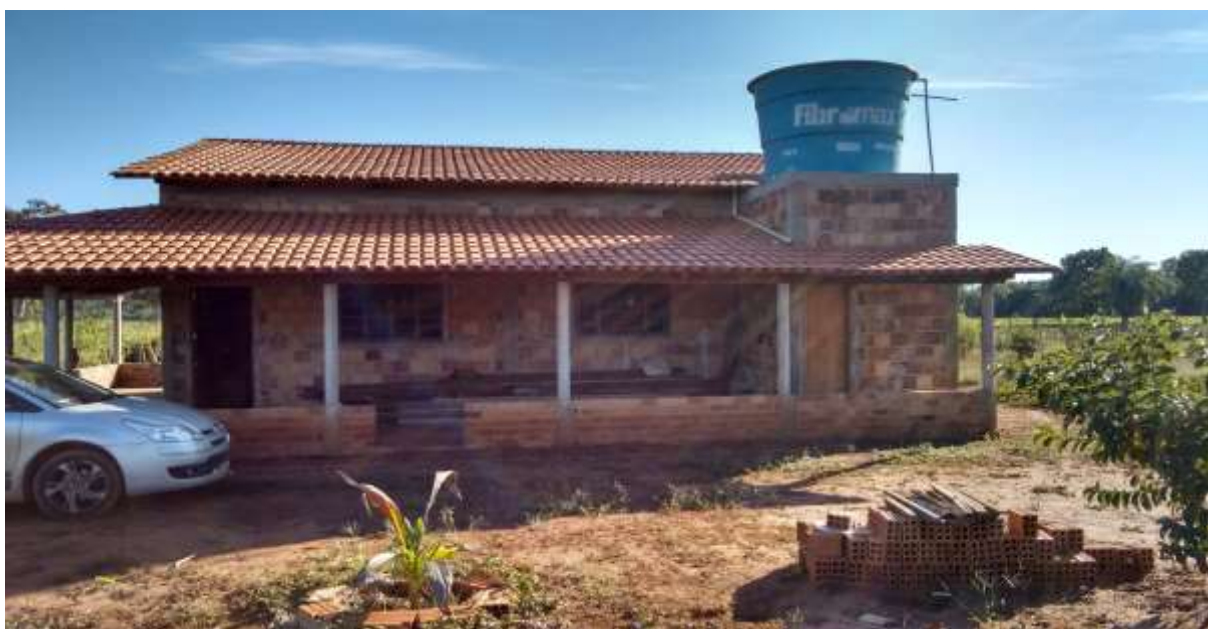
2- Fachada lateral direita da residência
